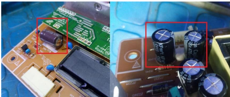
Figura 161. Capacitores dañados del monitor SAMSUNG modelo LS17HAAKS – Autoría propia
